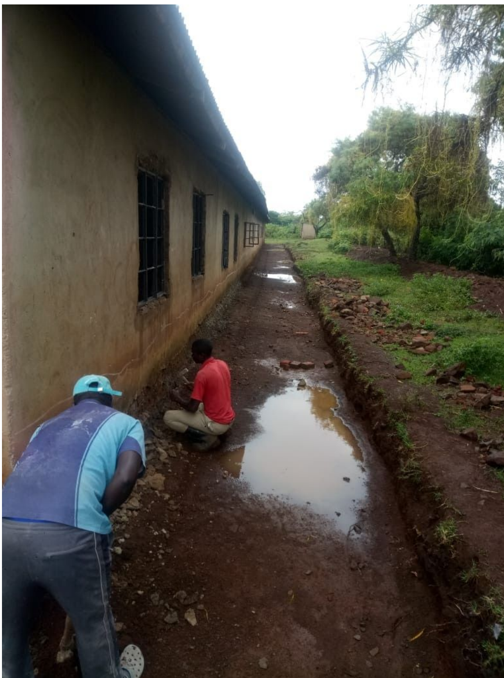
Inici de les obres de Rehabilitació a l'escola de primària Nyang'inja, a Katuk
